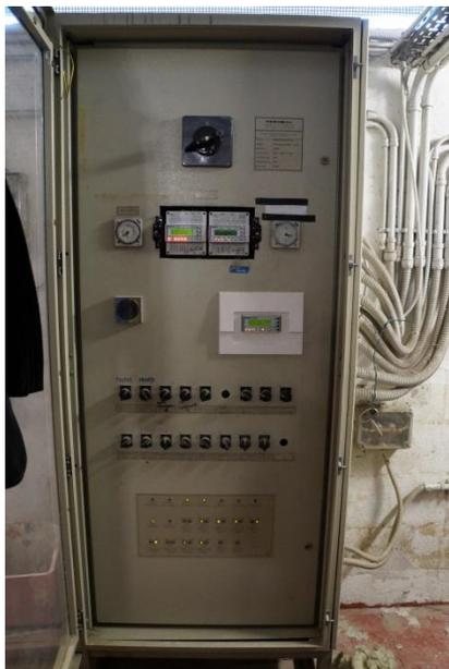
Figura 4.7 - Particolare della centralina di controllo dell'UTA a servizio della palestra
