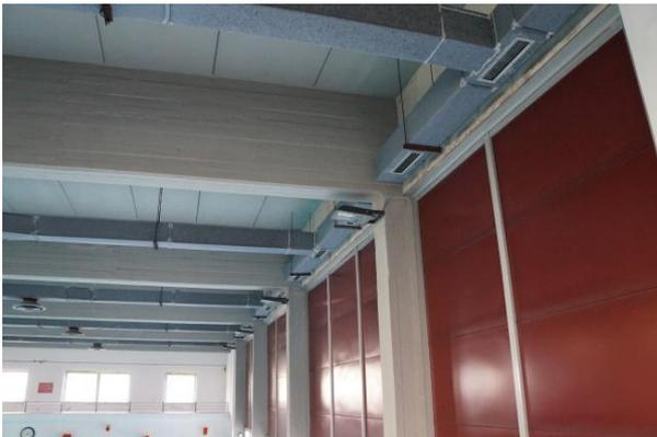
Figura 4.8 - Particolare delle bocchette di aerazione installate all'interno della palestra
