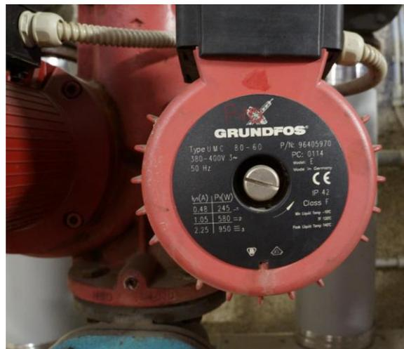
L'installazione di un circolatore elettronico a velocità variabile permette di ottimizzare tutte le prestazioni dell'impianto anche in termini di energia elettrica necessaria per l'alimentazione degli organi ausiliari. Inoltre viene prolungata la vita della pompa stessa.
